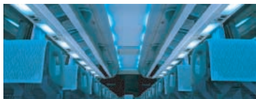
上質な室内を演出する、間接照明&冷房ダクト下面照明
